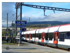
Déplacée, la gare vaudoise du Day termine sa transformation
